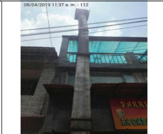
Fotografía No. 6 Ducto de desfogue del horno.
